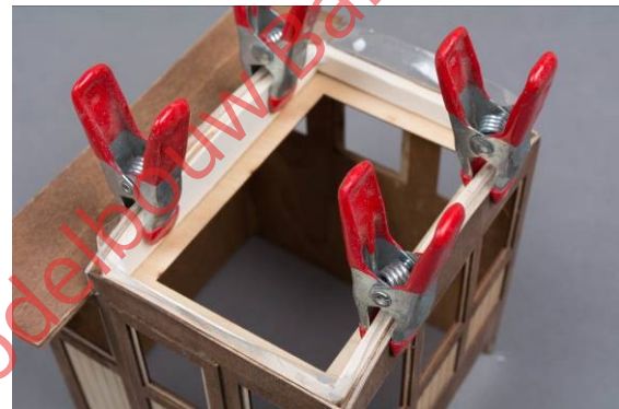
Fig. lijmen van het frame voor het dak
